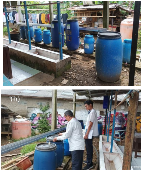
Gambar 5. Pengecekan Bak IPAL: (a) Kondisi Semua Bak, (b) Setiap Bak
