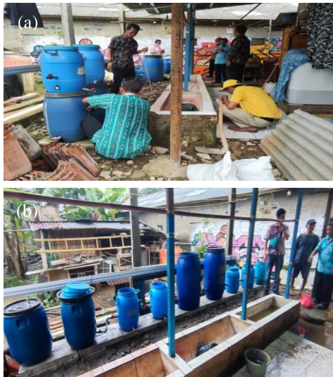
Gambar 3. Instalasi IPAL: (a) Pemasangan Rancangan Awal, (b) Percobaan Rancangan Awal di IKM Batik
